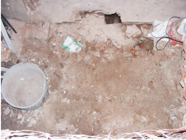
1. Vista del fossat de l'ascensor un cop retirat el nivell de circulació actual (UE 1)
