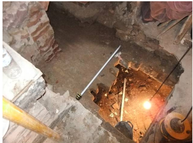
8. Foto final del buidat i desmuntatge.
