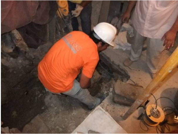
5. Demolició del paviment UE 03
